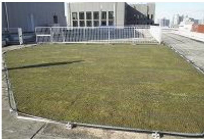
屋上緑化 100 m 2 (大阪市中央区)
