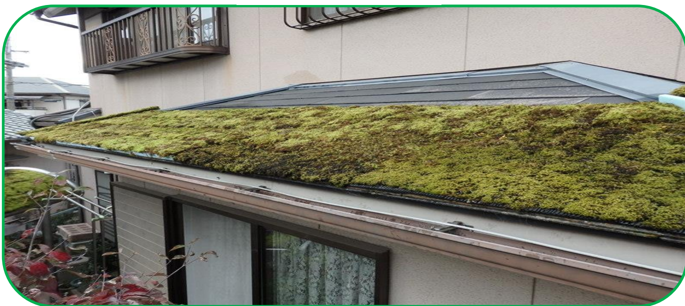
傾斜屋根緑化
